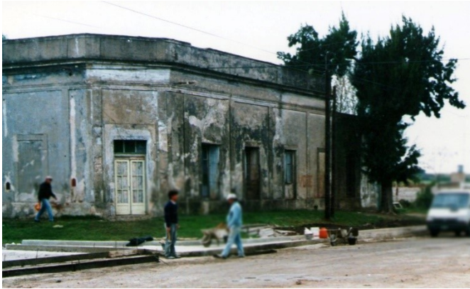
Figura 1. Edificio donde funcionaba la farmacia "botica" de Don Stelio Vatta y donde trabajó como dentista Miguel Tomarinson. Fue demolido en el año 2000. La fotografía es de 1989/90. Hacia el año 1965 todavía se podía leer el cartel en el frente: Botica Friulana.
